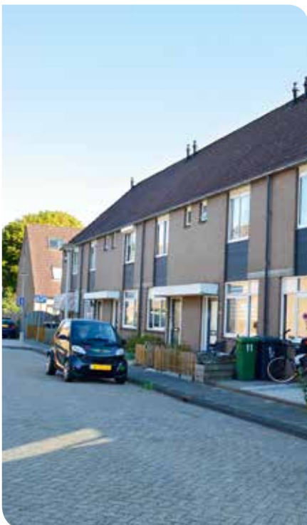
In de wijk Akkers onderzoekt Maasdelta Groep of er in de huizen asbest aanwezig is
